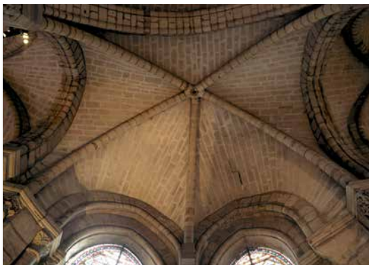
Voûtes d'une chapelle du chœur de Suger
