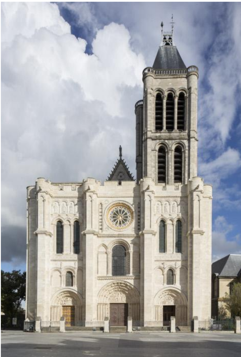
Basilique cathédrale Saint-Denis, façade occidentale © Pascal Lemaître / Centre des monuments nationaux
